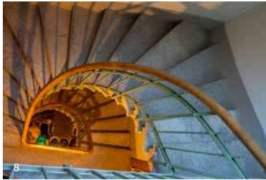
7— Ehemaliges Dienstbotenzimmer im Dachgeschoss. 8— Wendeltreppe ins Dachgeschoss für Dienstboten. 9— An die englische Arts and Crafts-Bewegung erinnernde Originalbeschläge aus der Bauzeit.
