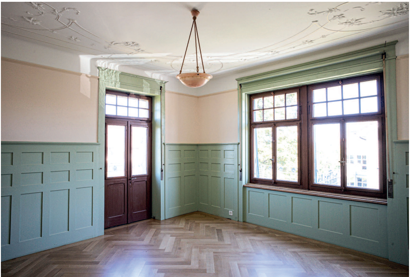
Schlafzimmer im ersten Obergeschoss in neuem Farbkleid und (kleines Bild unten) im Zustand 2007.
